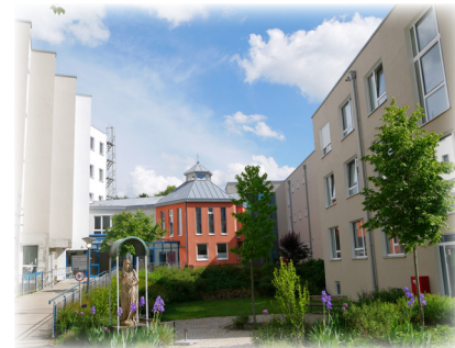
Das neue Altenzentrum mit der Kapelle als baulichen Mittelpunkt.
